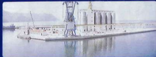
TMO - Steel Grain Silos - Rize (TURKEY)
